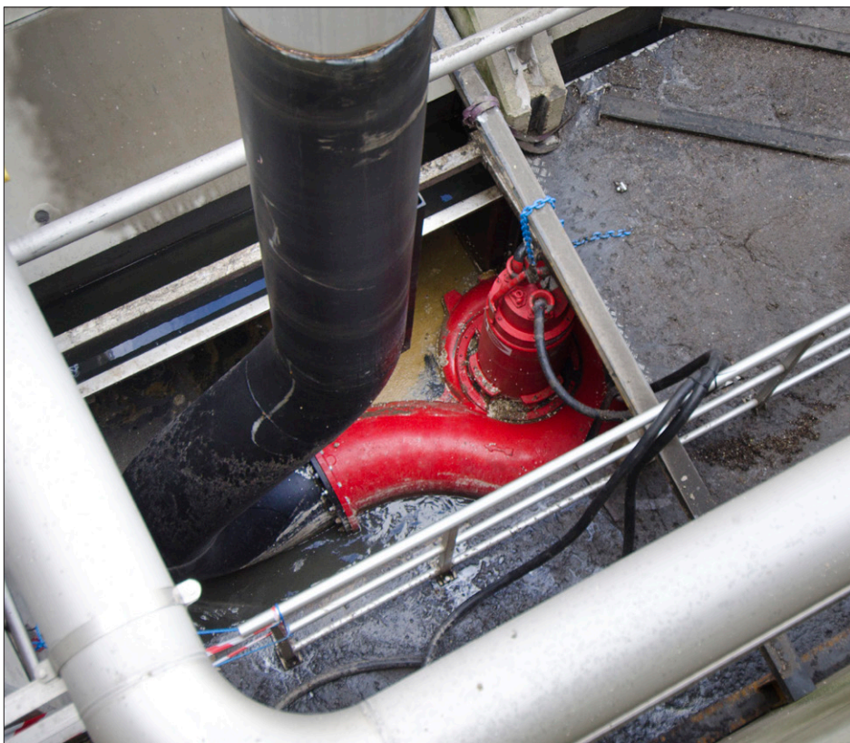
Midlertidig overpumpningsopgave i Aalborg. 4100 m 3 /h x 10 mVs.
